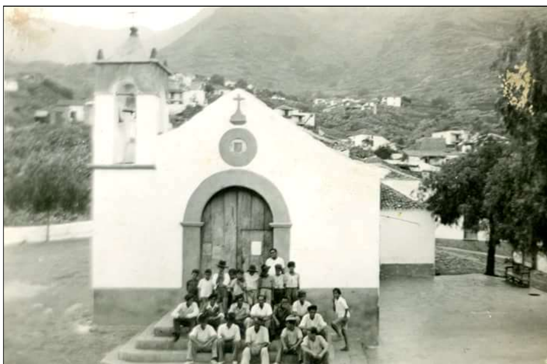
La iglesia de la Santísima Trinidad de Iguste, antes de su reforma.
