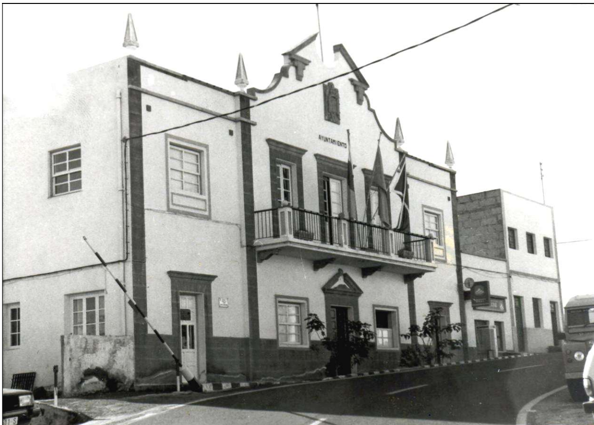
El Ayuntamiento viejo fue la sede del Patronato para la Protección y Fomento de las Bellas Artes “Amigos del Arte de Fasnía”, antes de la reforma que le dio su conocido aspecto.
