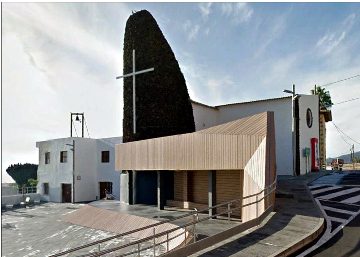
El templo de San Andrés de Las Cuevecitas, con su estructura actual y la plaza anexa.
