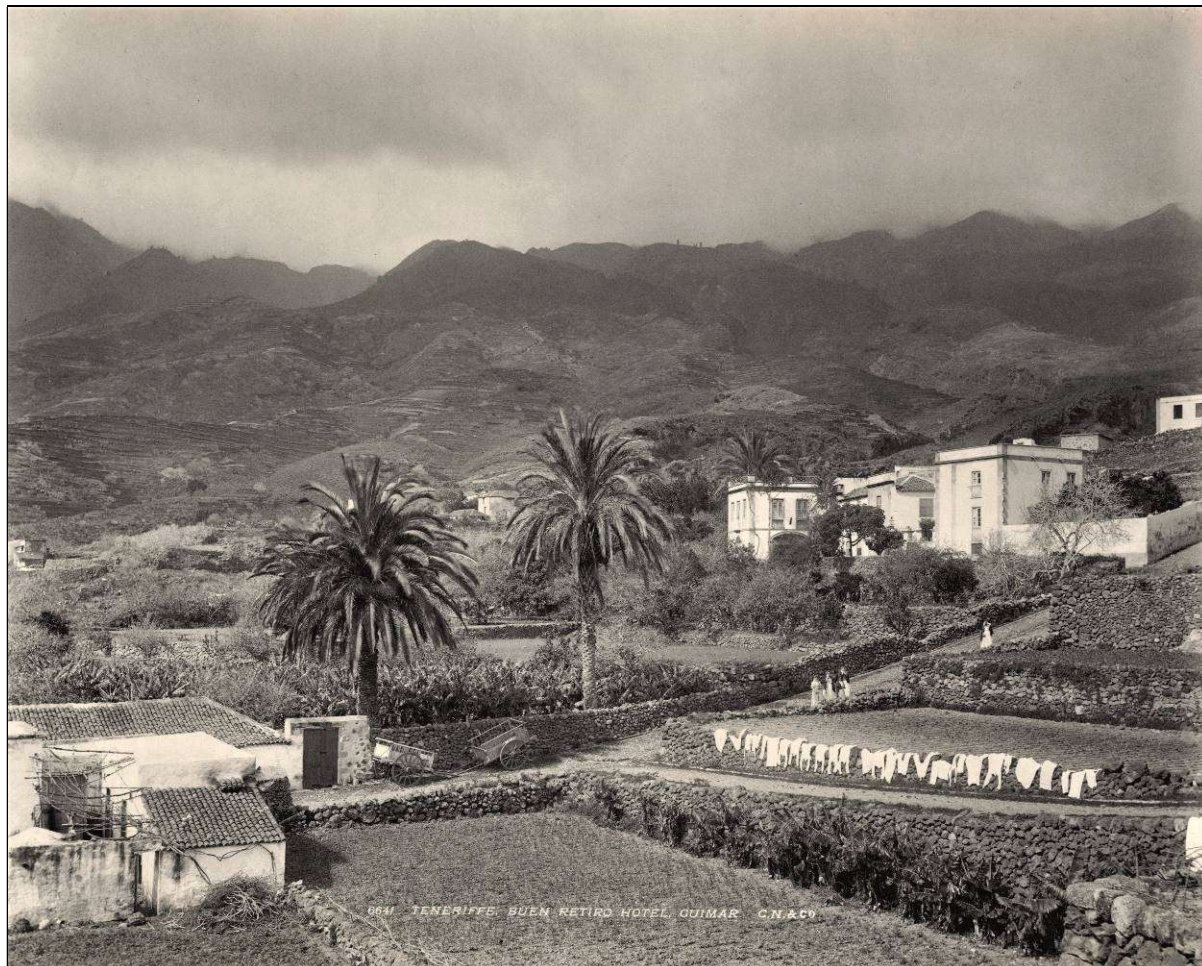
Casa familiar de don José Delgado Trinidad en Chacaica (Güímar), en la que nació y falleció. En ella estaría instalado el recordado Hotel “El Buen Retiro”. [Foto de Carl Norman, 1893].
