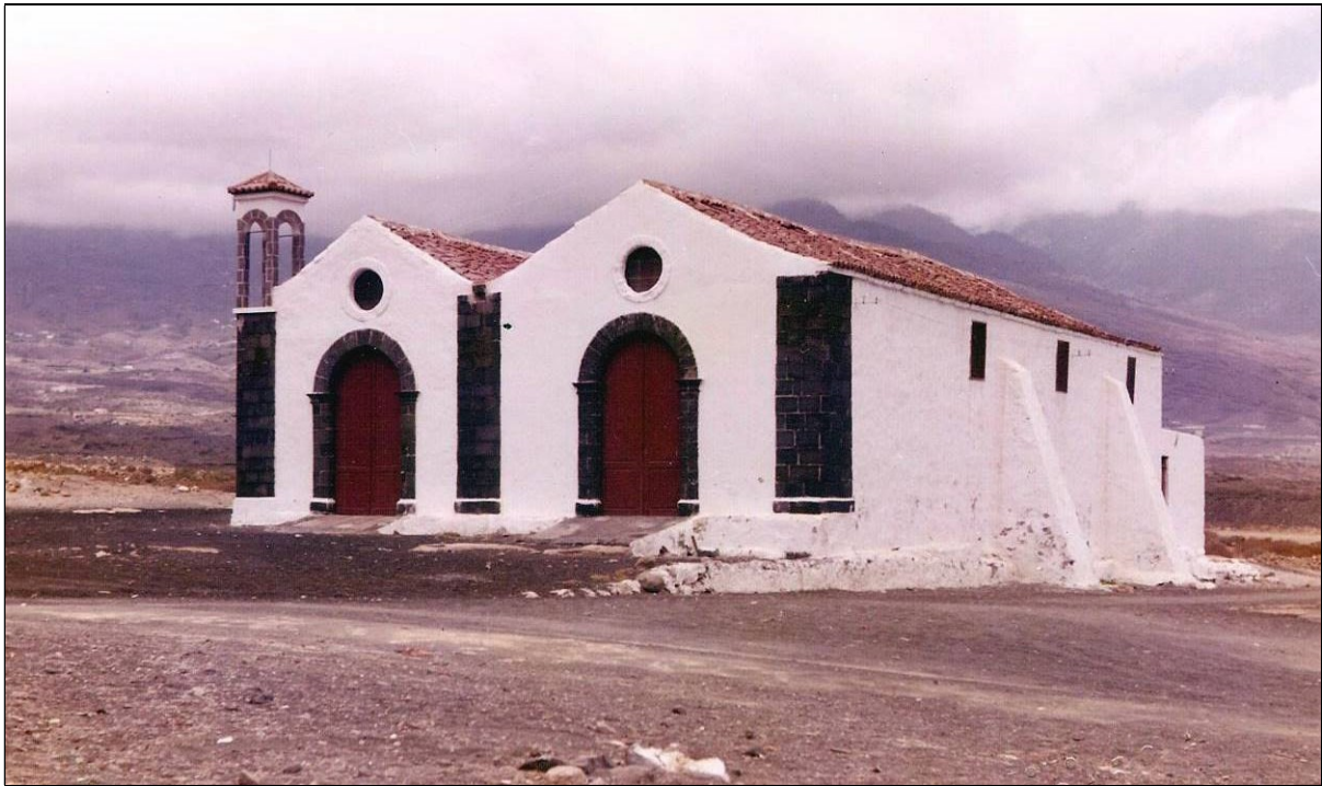
En 1894 se bendijo la segunda nave de la ermita de El Socorro.
