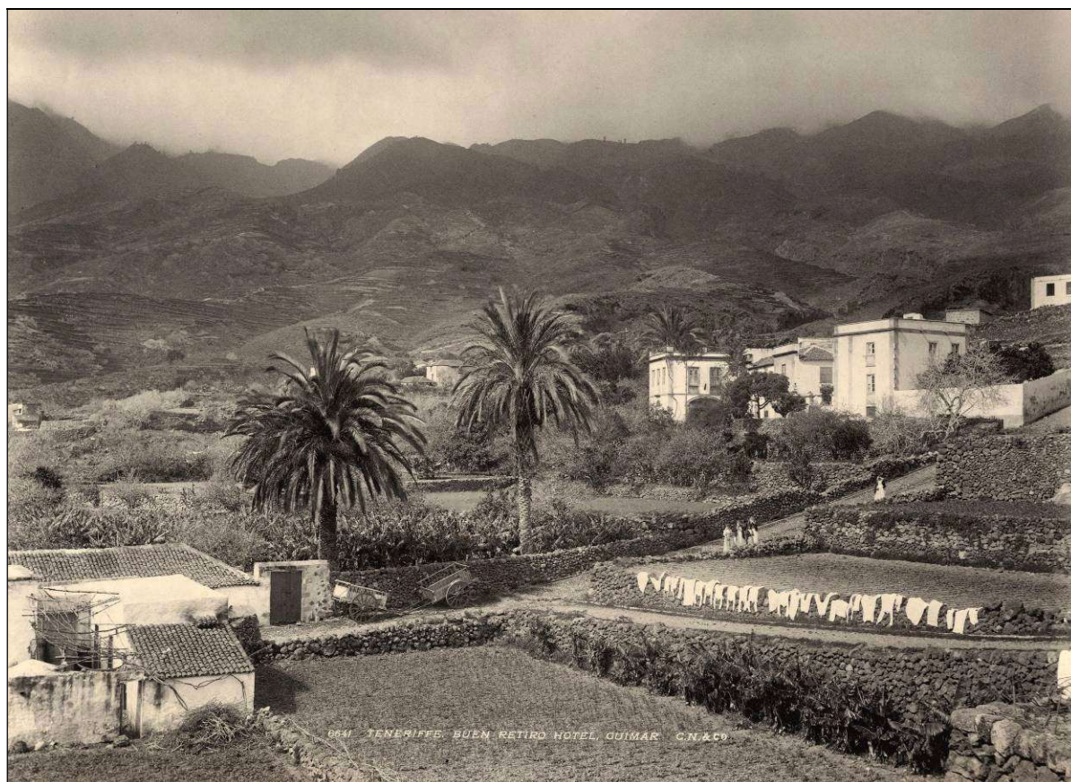
Antiguo caserón de la familia Delgado-Trinidad, donde estuvo instalado el Hotel “El Buen Retiro” y luego el Convento-Colegio de Religiosas Dominicas de Güímar. [Foto de la FEDAC].
