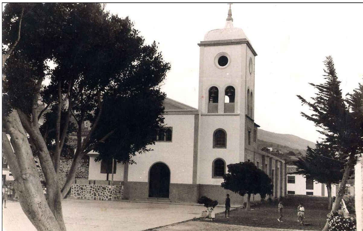
La iglesia de San Joaquín de Fasnía tras su reconstrucción y antes de su reciente reforma.
