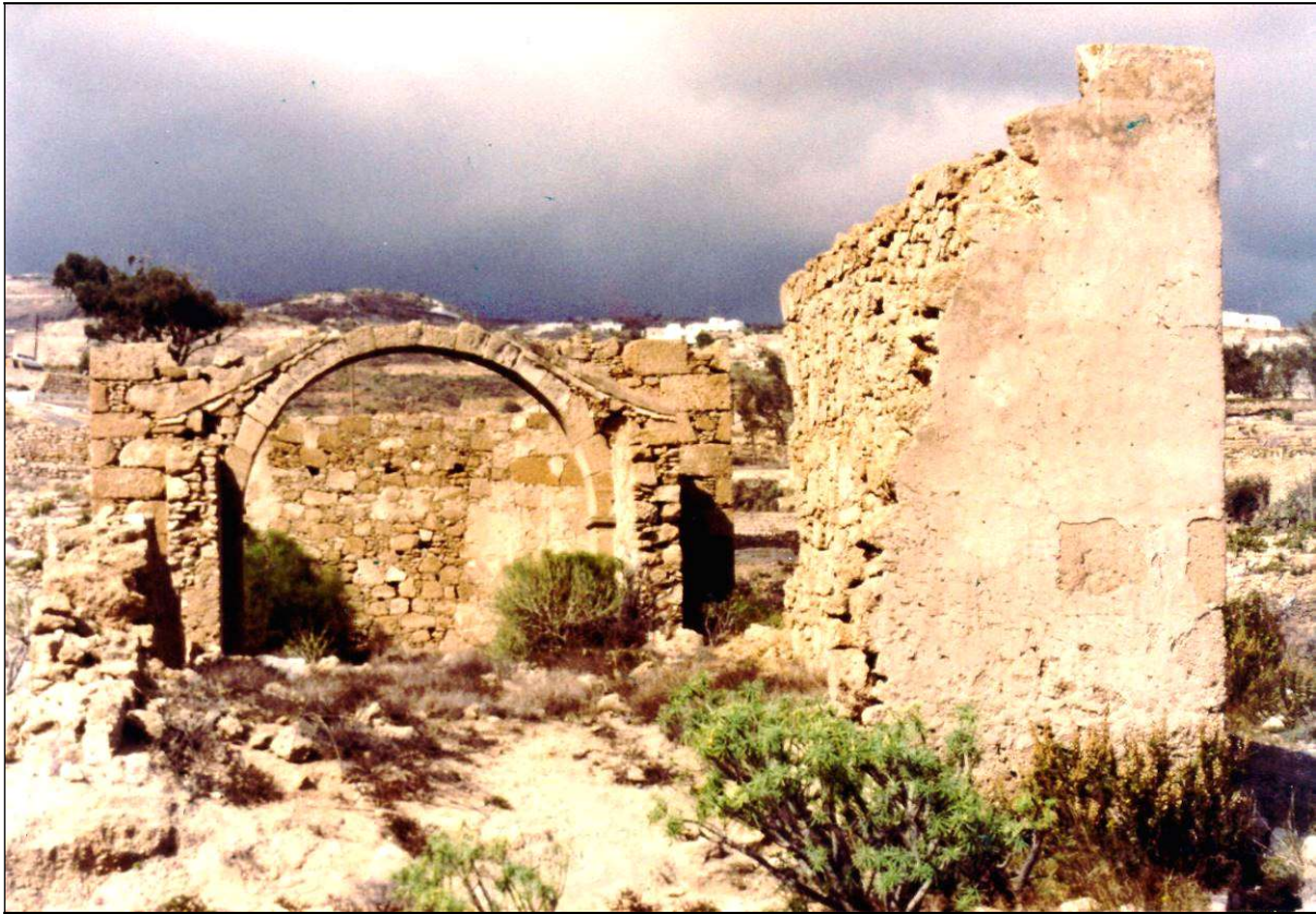
Ruinas de la “Iglesia vieja” de Fasnía, sede inicial de la parroquia de San Joaquín, así como de las hermandades y cofradías creadas en ella, antes de las labores de rehabilitación.
