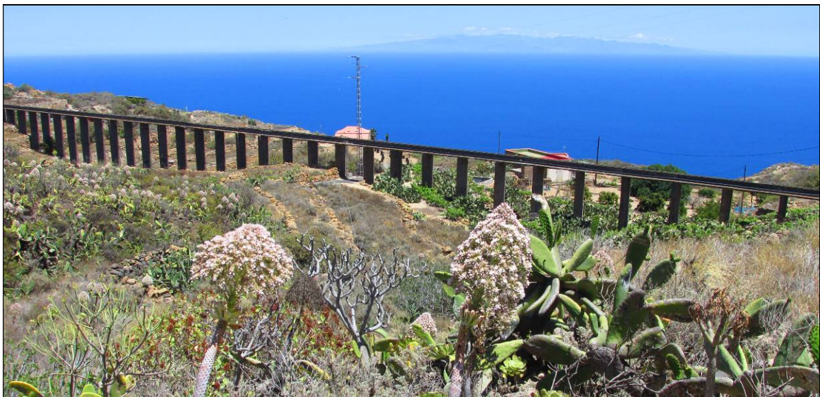
El conocido acueducto del “canal de Güímar” a su paso por Lomo de Mena.
