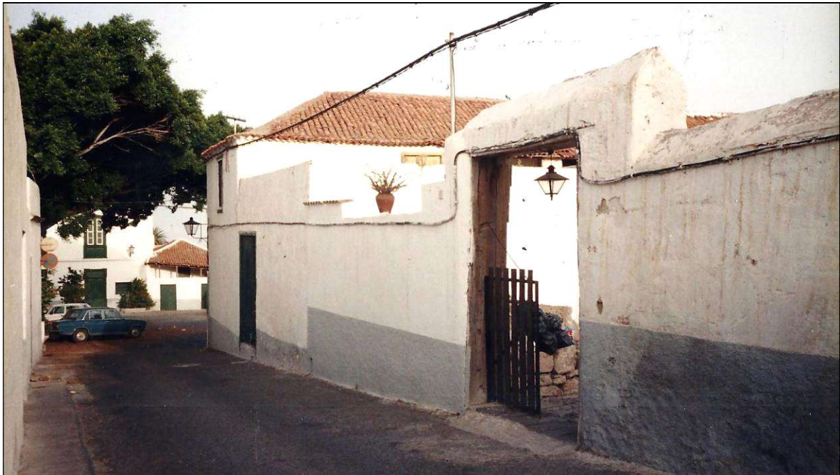
Casa “ El Patio de don Diego ” en Arico el Nuevo, en la que nació, vivió y murió don Diego de Torres.
