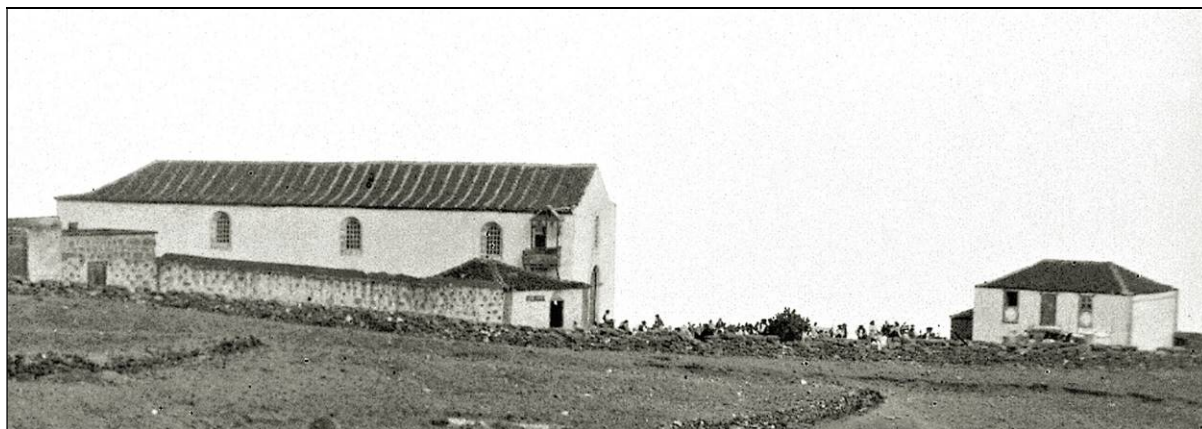
La iglesia de San Joaquín de Fasnía a finales del siglo XIX, antes de su destrucción y posterior reconstrucción. [Imagen del Centro de Fotografía “Isla de Tenerife”].
