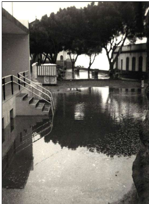
Antes de pavimentar la calle de acceso a la plaza, con las lluvias intensas se formaba un enorme charco que impedía el paso por esta vía.
