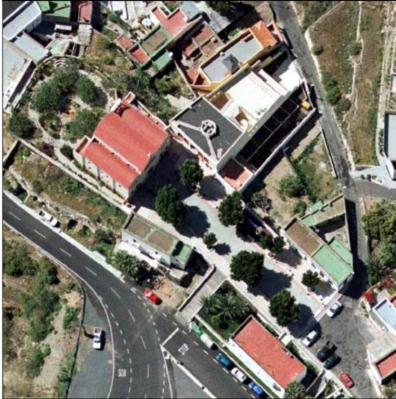
Visión aérea de la Plaza en 2008, con su entorno y el aspecto que tenía antes de la reforma actual. Foto de GRAFCAN.
