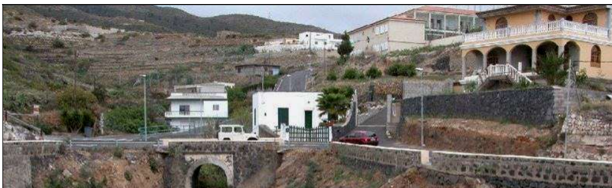
Al centro y junto al puente de La Hendía, la casa en la que vivió don Antonio José Cubas Padilla [Foto de Roberto Chico Pérez].
