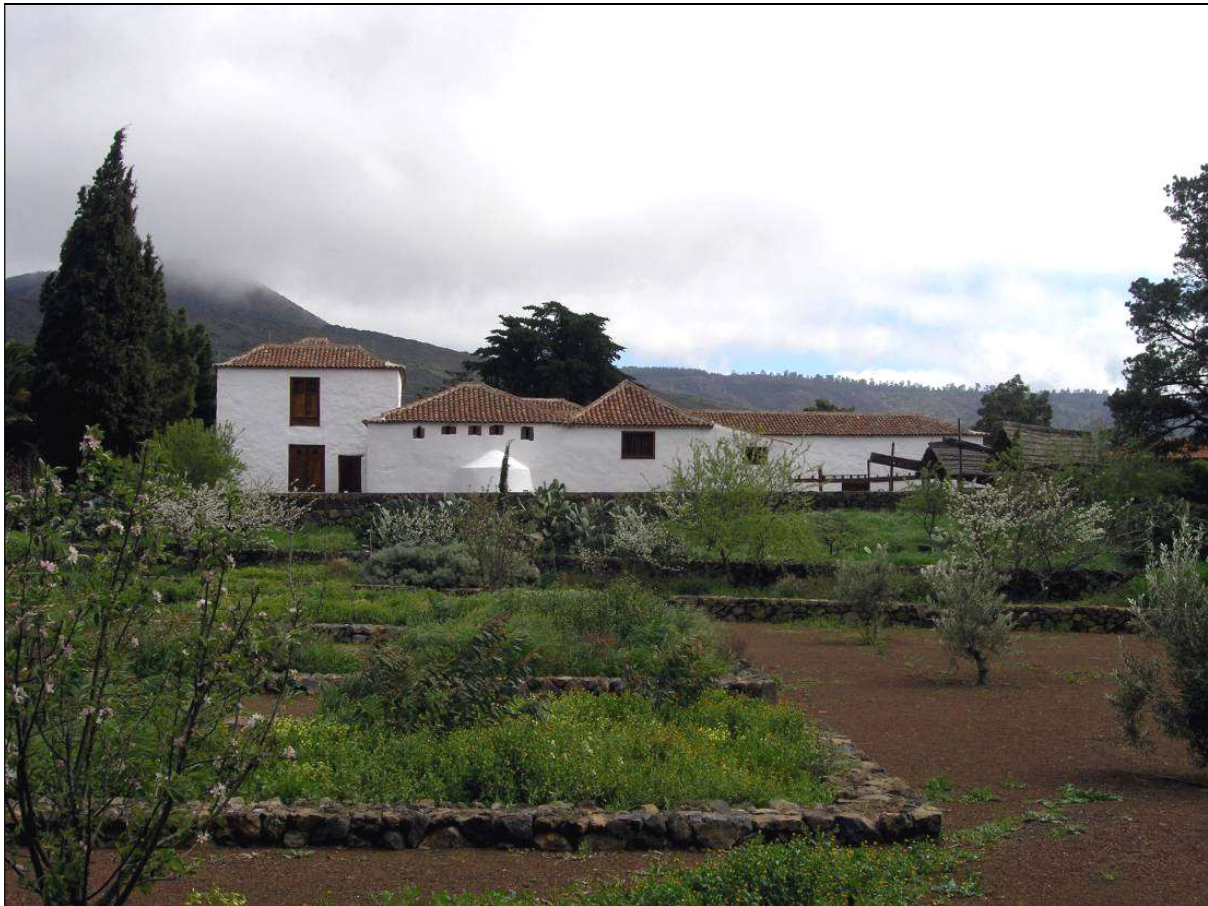
El maestre de campo y primer Señor de la Villa de Santiago, don Fernando del Hoyo Solórzano falleció en la Casa del Patio.
