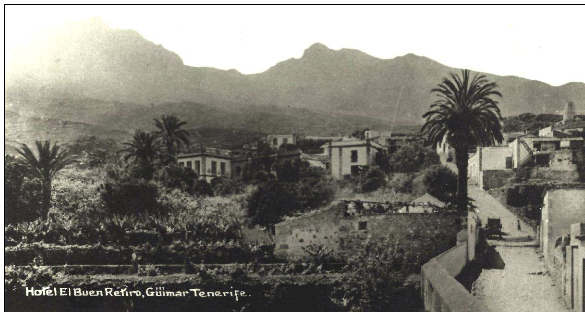
Casa familiar de don José Delgado Trinidad en Chacaica (Güímar), en la que nació y falleció. En ella estaría instalado el recordado Hotel “El Buen Retiro”.
