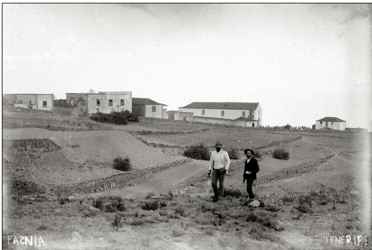
Don Domingo continuó actuando como notario público y sochantre, tras el traslado de la parroquia a la nueva iglesia de San Joaquín, que se aprecia en la foto.
