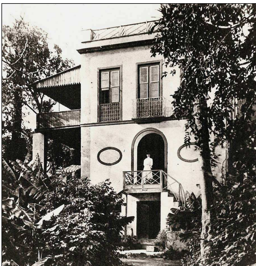
Otro aspecto del edificio en el que estuvo el Convento-Colegio de Religiosas Dominicanas.
