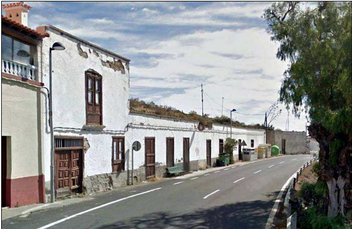
Casas de la familia Castro Díaz en La Medida, junto a la Carretera General del Sur.
