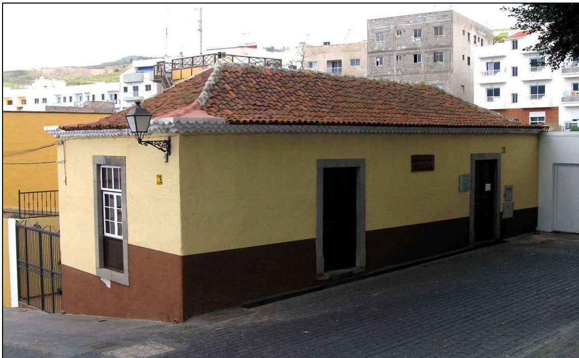
El antiguo edificio de las casas consistoriales (hoy biblioteca), construido por iniciativa de don Francisco Guzmán y Cáceres y don Miguel Alfonso Martínez.
