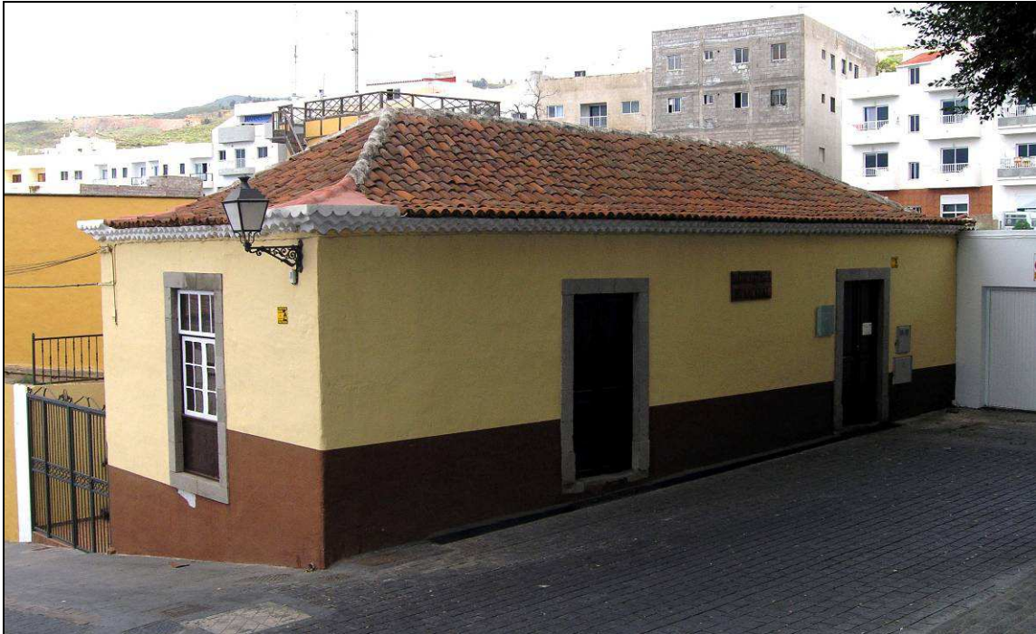
El antiguo edificio de las casas consistoriales (hoy biblioteca), construido por iniciativa de don Francisco Guzmán y Cáceres y don Miguel Alfonso Martínez.
