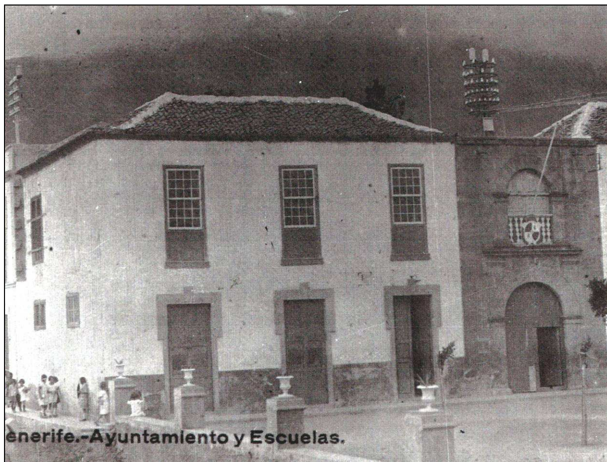
En los años veinte, las escuelas y el Ayuntamiento compartían edificio.
