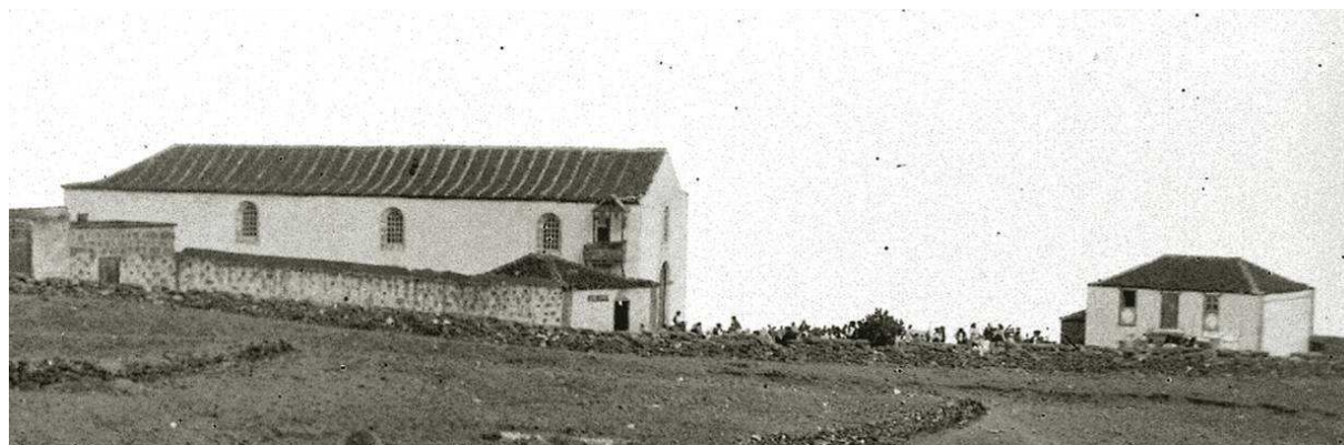
Antigua iglesia parroquial de San Joaquín de Fasnía, desplomada un año antes de este informe y durante la regencia de don Luis Navarro, quien dedicó todos sus desvelos a la reconstrucción. A la derecha, la casa parroquial.
