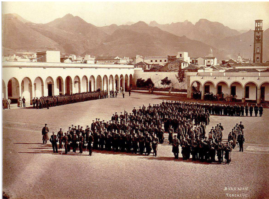
El cuartel de San Carlos de Santa Cruz de Tenerife, sede del Batallón de Cazadores en el que don Manuel Bello prestó sus servicios.
