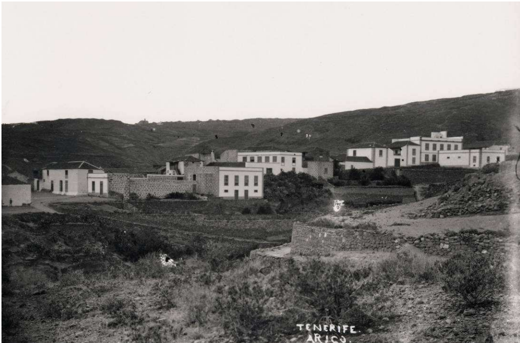
En Arico, el Sr. Peraza y Ayala culminó su carrera militar y ostentó los cargos de alcalde real, rematador de diezmos, recaudador de la contribución y mayordomo de la ermita de Abona.
