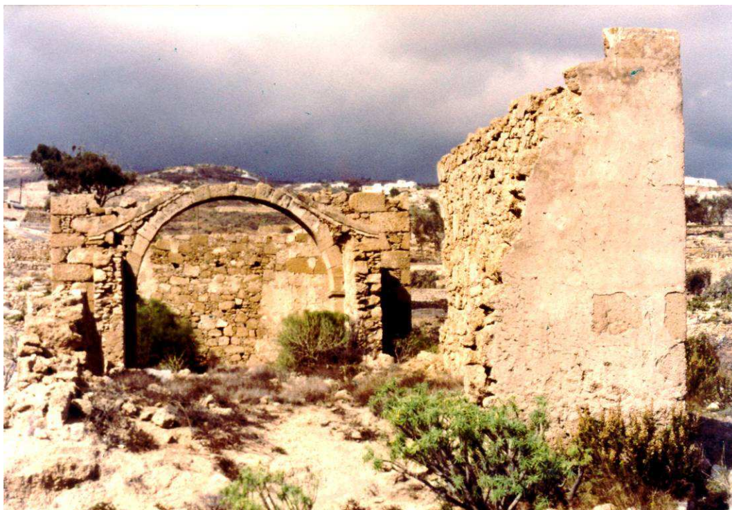
El único edificio público que existía en 1779 en el actual término de Fasnía era la "iglesia vieja" de San Joaquín.
