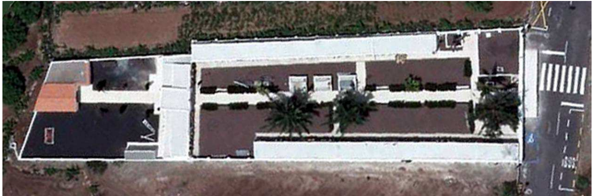
El cementerio municipal “ San José ” de Barranco Hondo, con todas sus instalaciones, en 2010. [Fototeca de GRAFCAN].
