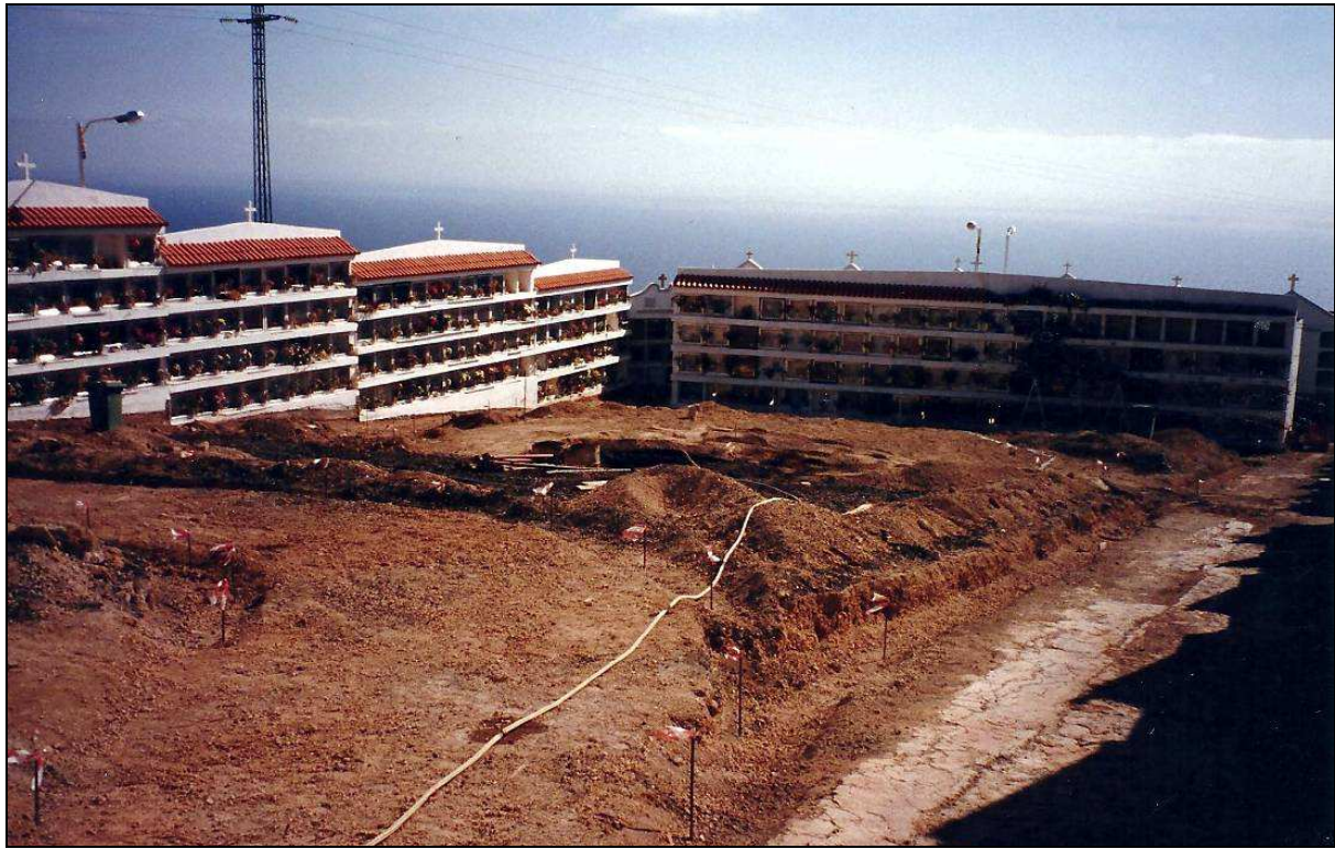
Obras de mejora y remodelación del cementerio municipal, en 1995.
