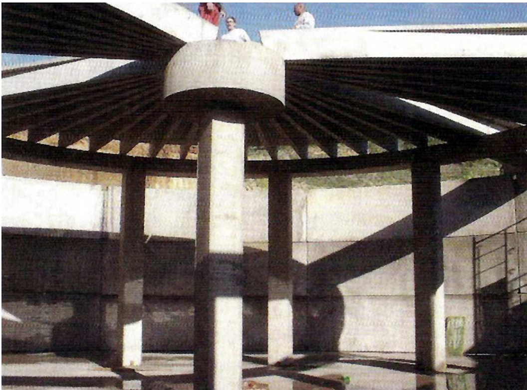
El actual depósito de cabecera de El Escobonal, cuando aún estaba en construcción en la parte alta de la Tambora de Arriba, en la zona conocida como Los Escobones.
