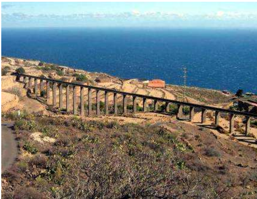
El canal de Güímar a su paso por el acueducto de Lomo de Mena.
