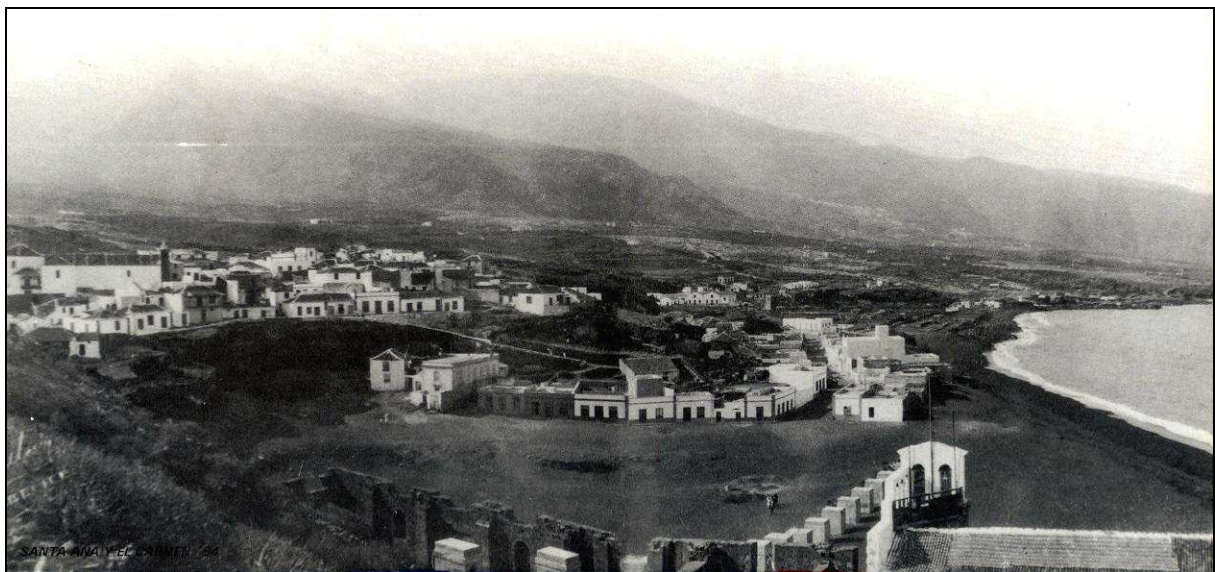
Vista panorámica de Candelaria en el primer tercio del siglo XX. En primer plano, los antiguos muros del “Cementerio del Convento”.
