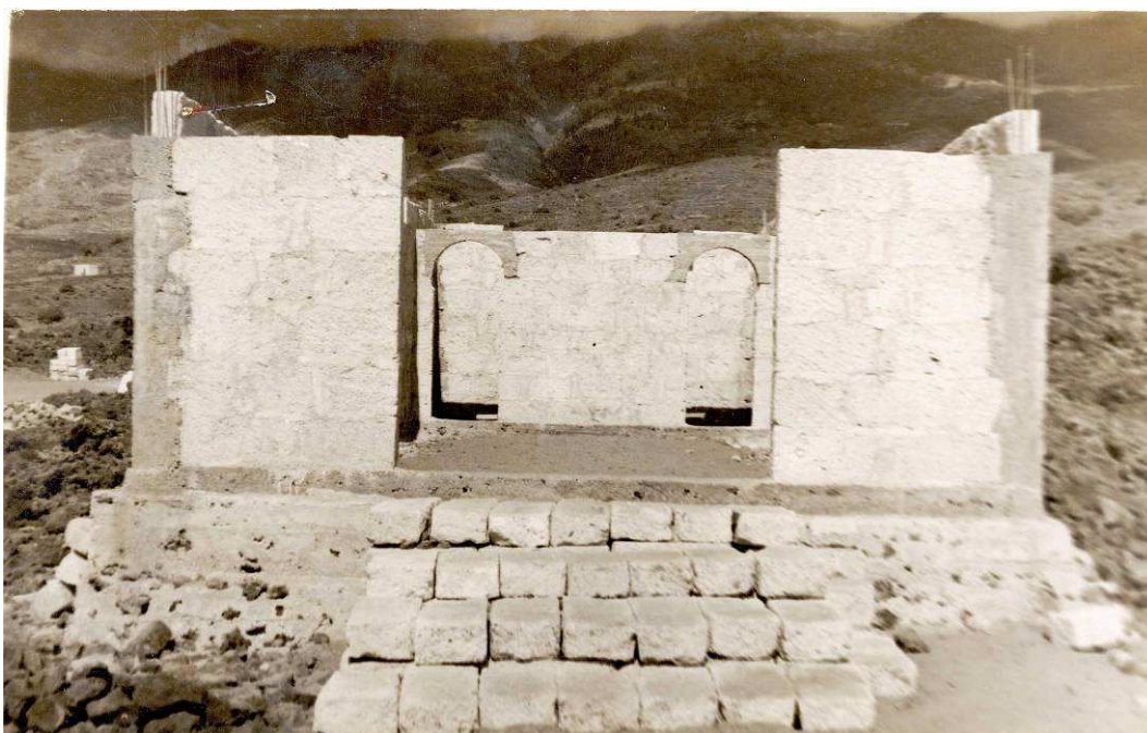
La capilla de la “ Barriada del Volcán ” en construcción (mayo 1955). [Foto del Archivo Municipal de Güímar].
