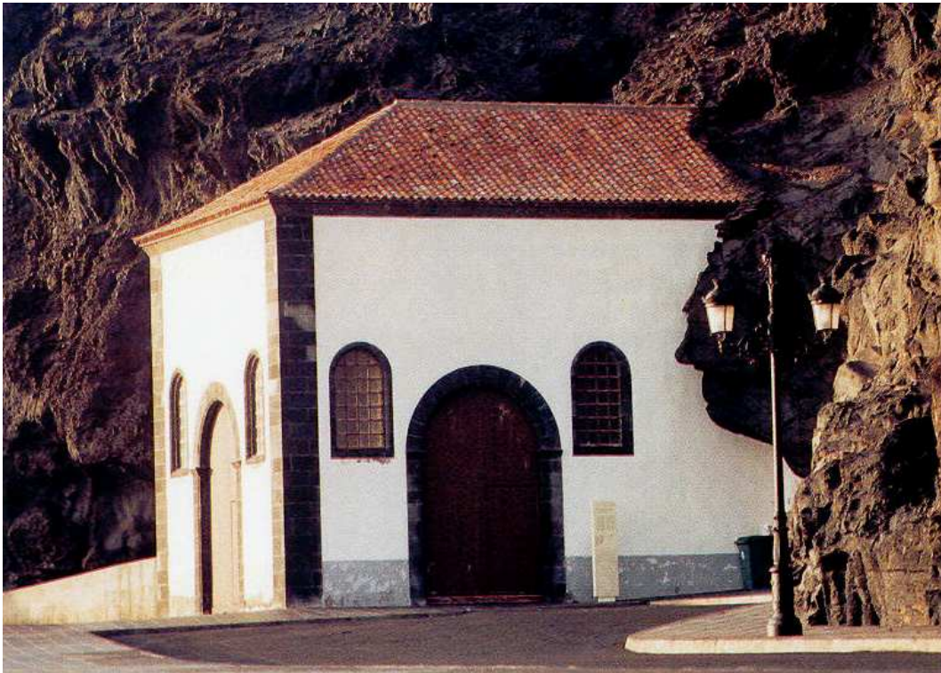
La Capilla construida en 1790, como ampliación de la Cueva de San Blas, para aumentar su capacidad y habilitar cerca de cien sepulturas.
