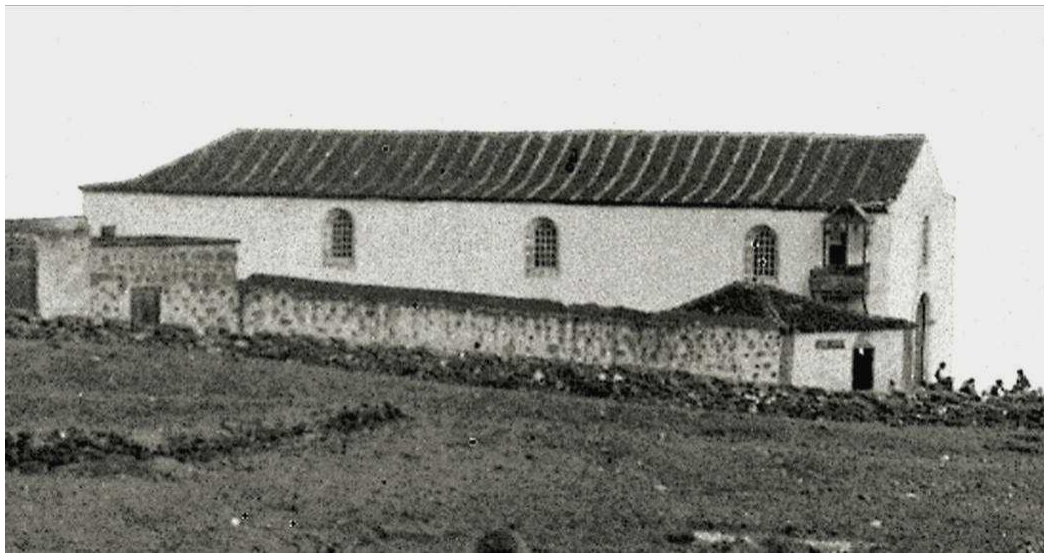
Nueva iglesia parroquial de San Joaquín de Fasnía, construida en el solar donado en parte por don José Díaz Flores y su esposa, y en la que ambos fueron enterrados.
