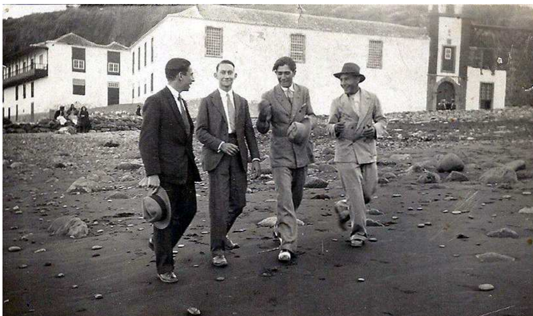
Al fondo, a la izquierda, unas mujeres sentadas en los cimientos del Castillo de San Pedro. Foto reproducida por Manolo Ramos (2006) y por Candelaria Forever.
